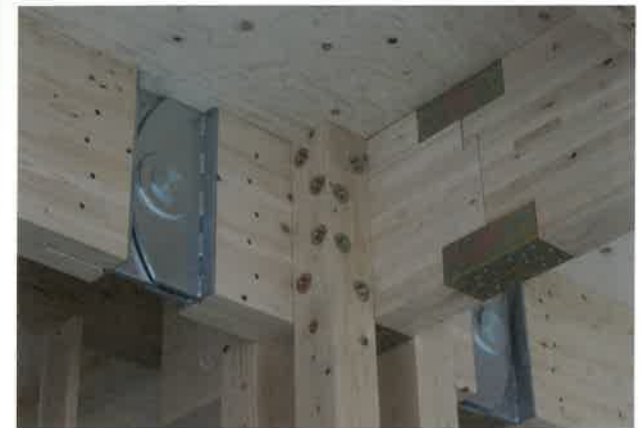
囲柱ラーメン木構造では、岐阜県産の柱4本(杉105角)と梁(杉集成材、梁せい240)を専用金物で締結
