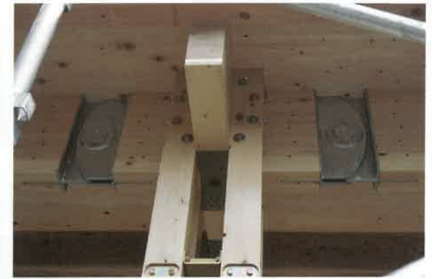
囲柱ラーメン木構造では、岐阜県産の柱4本(杉105角)と梁(杉集成材、梁せい240)を専用金物で締結
