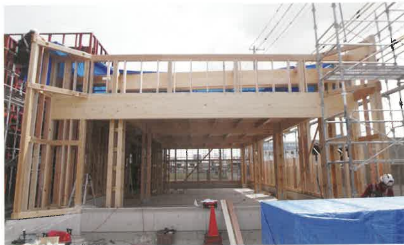
最大スパン8mの開口部には梁せい690mmの桧集成材
