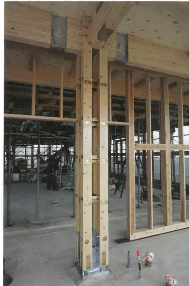
囲柱ラーメン木構造では、岐阜県産の柱4本(杉105角)と梁(杉集成材、梁せい240)を専用金物で締結
